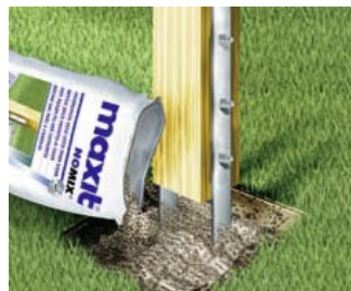
3. nasypat beton maxit no mix
